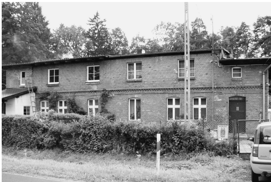
Ryc. 26. Grzybno. Budynek mieszkalny (wielorodzinny). Fot. W. Witek, 2007
