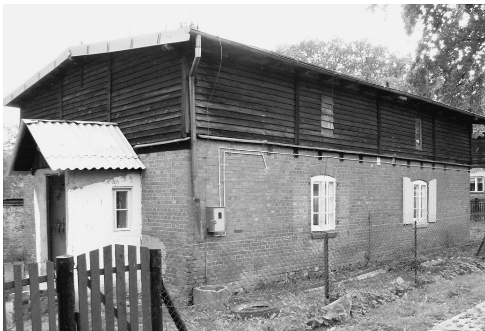
Ryc. 25. Pątnowo. Budynek mieszkalny (dwojak). Fot. W. Witek, 2007
