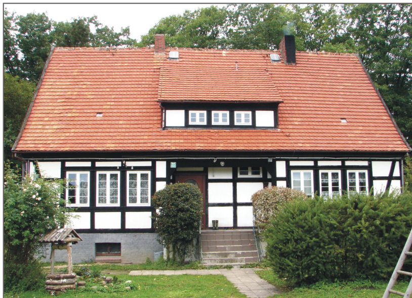
B. Radosław. Ryglowa leśniczówka - elewacja podwórzowa. Fot. W. Witek, 2007
