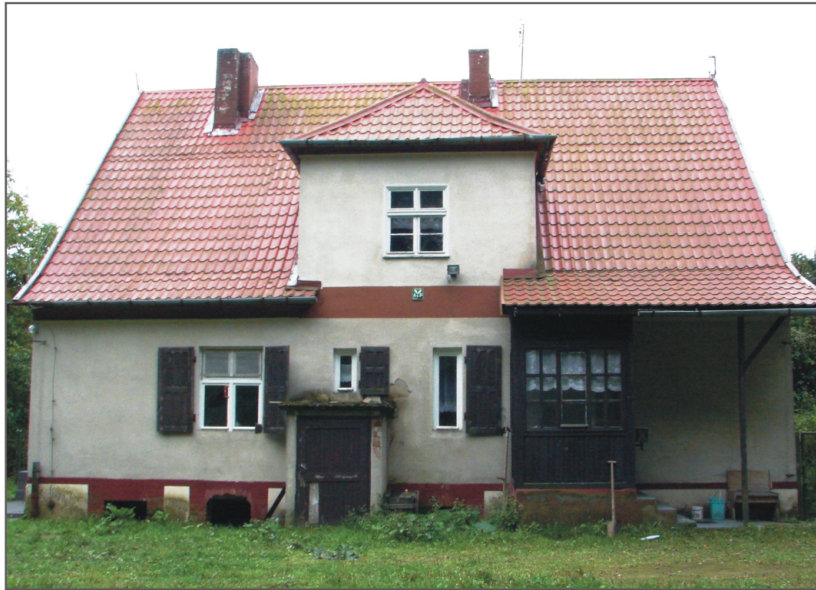
A. Przemysławiec. Leśniczówka - elewacja podwórzowa. Fot. W. Witek, 2007
